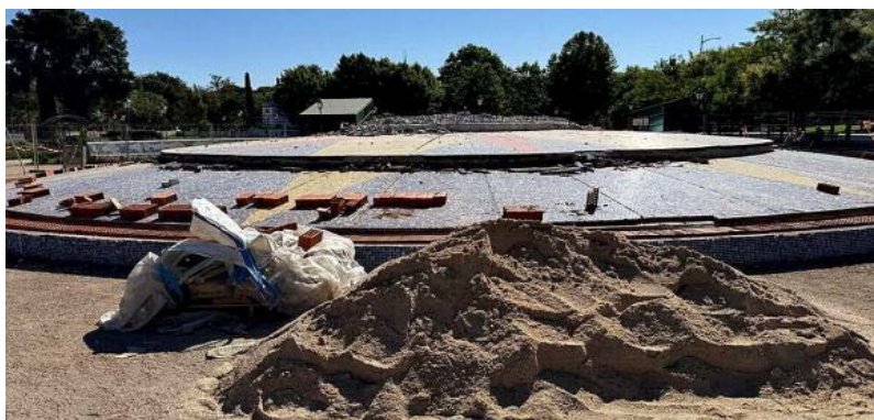
Una de las dos fuentes que se están rehabilitando, situada en la ampliación de los Jardines del Prado. / C.S.J.
