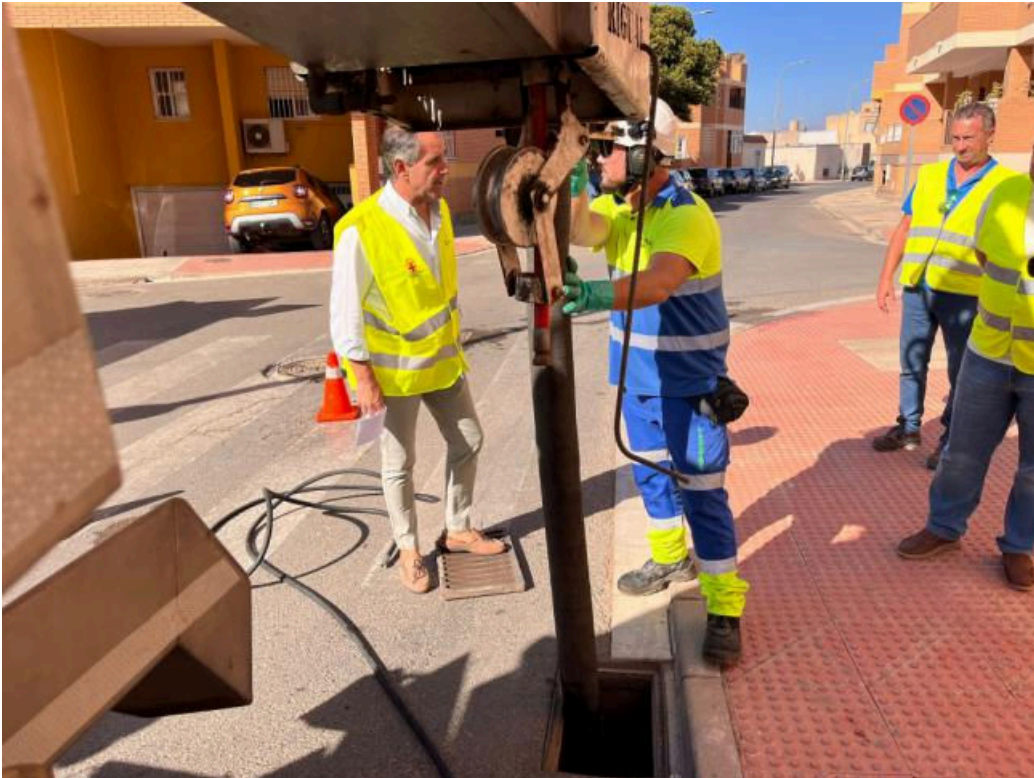
2.450 horas de trabajo. Así se limpian las alcantarillas de Almería antes de las lluvias
