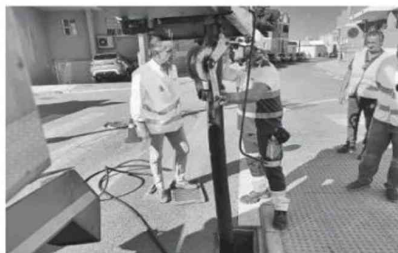
Visita del concejal a la limpieza de tuberías. LA VOZ
