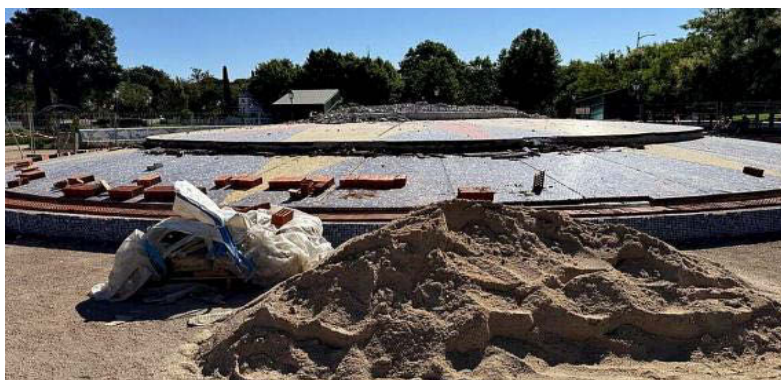
Una de las dos fuentes que se están rehabilitando, situada en la ampliación de los Jardines del Prado. / C.S.J.
